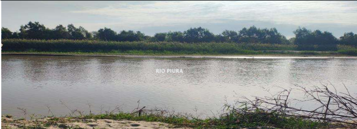
FIGURA N°01: TRAMO CRÍTICO EN EL RIO PIURA, EN EL SECTOR EJIDOS DEL NORTE, DISTRITO DE PIURA, PROVINCIA DE PIURA - PIURA.
